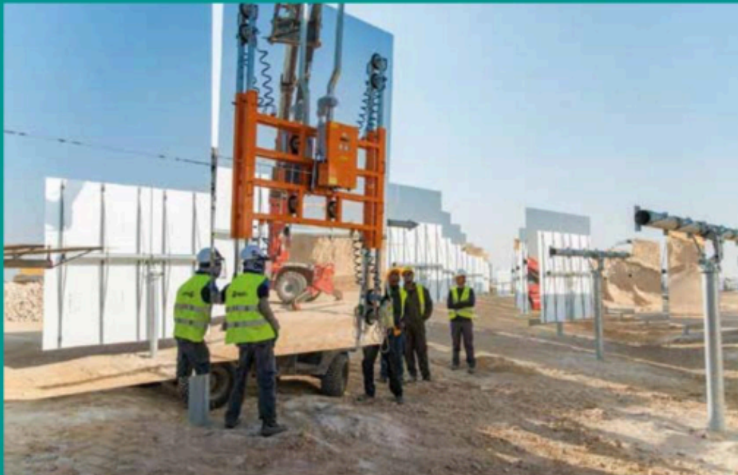
Het plaatsen van de enorme spiegels van het Ashalim-project. (foto Bright Source Energy)
