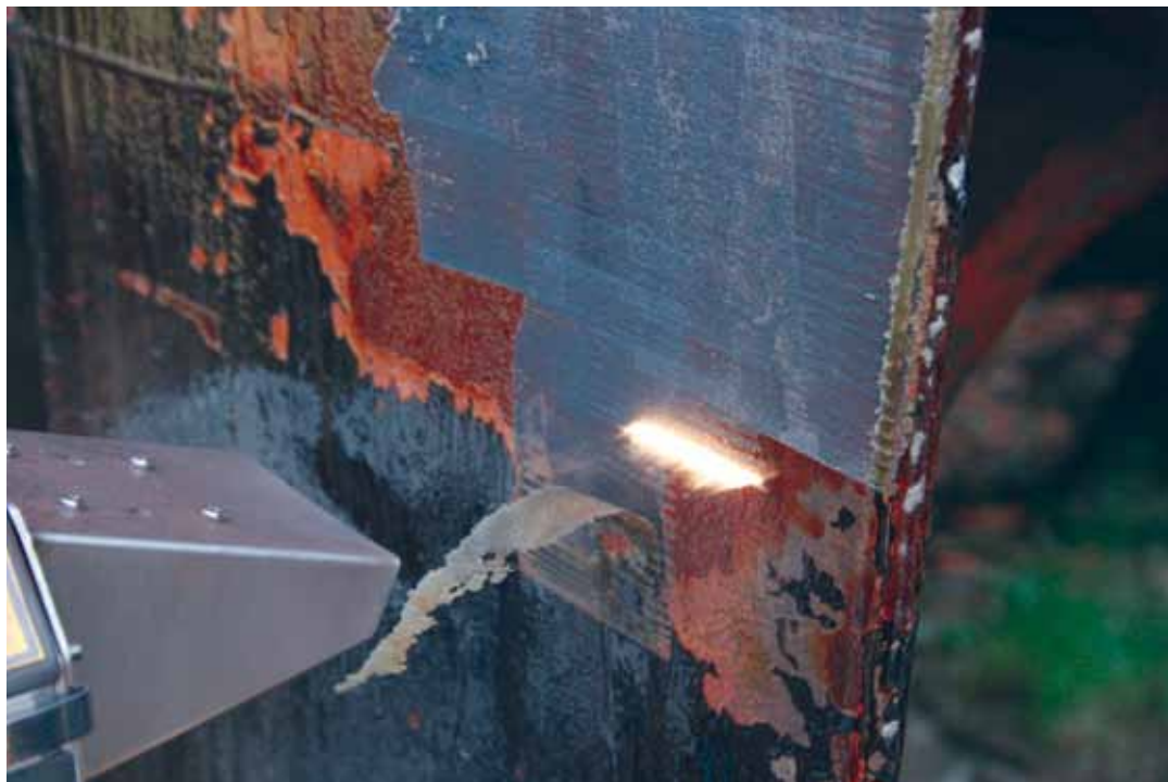
Laserontroesten op locatie. (Foto: Mitraco/P-Laser, België)
