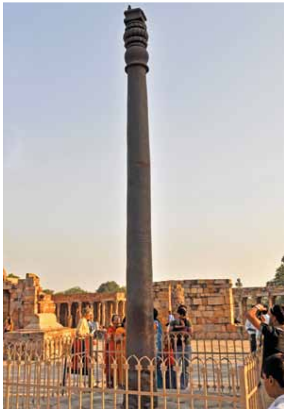
Diverse verklaringen circuleren voor de niet-roestende Iron Pillar in Delhi, India: al 1.600 jaar zonder corrosie door de uitzonderlijke vaardigheid van de smeden van rond het jaar 400... een fosfaatlaagje aan het oppervlak? Of bijzondere bescherming vanuit de onzichtbare wereld? (foto: Jan S. Shutterstock)
